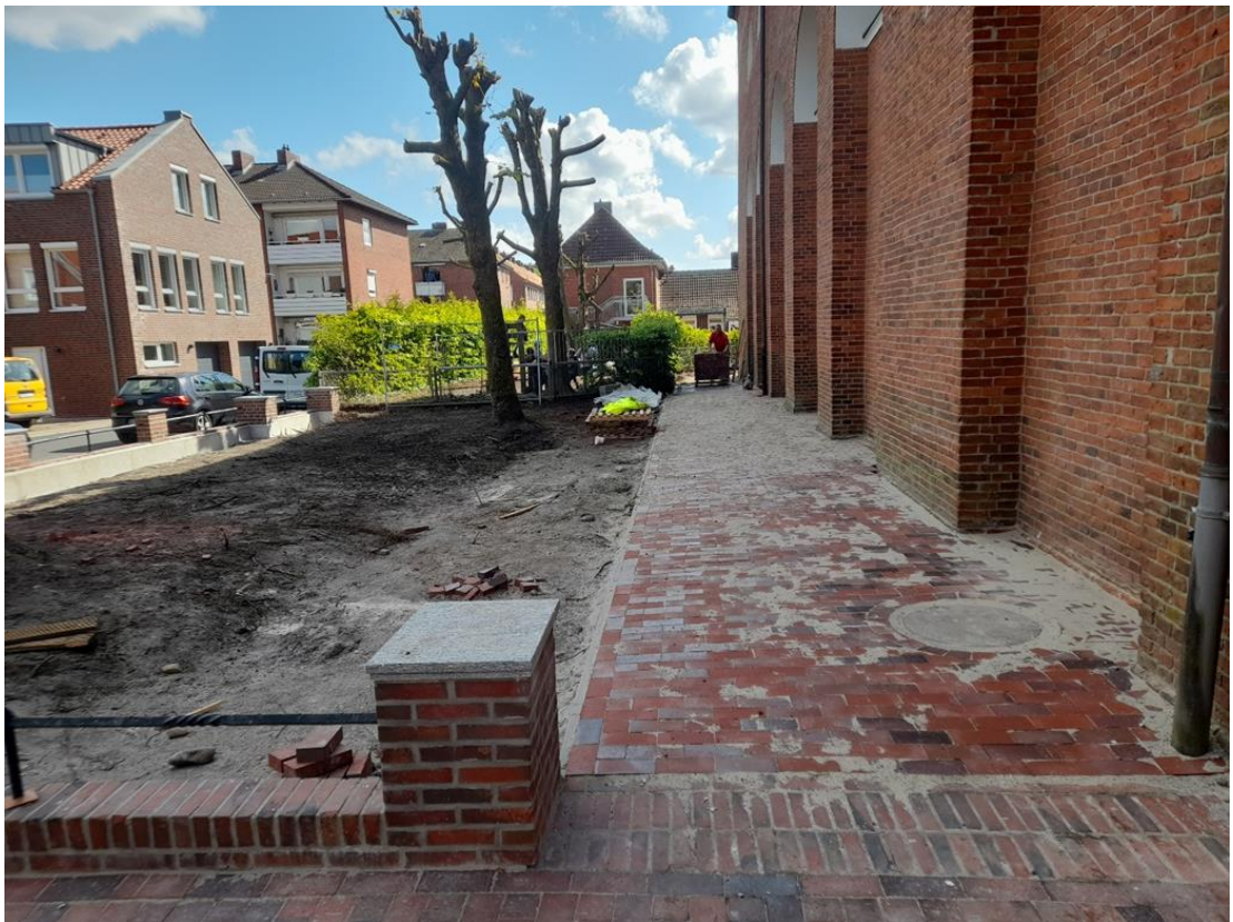
Der Außenbereich wird gepflastert.
